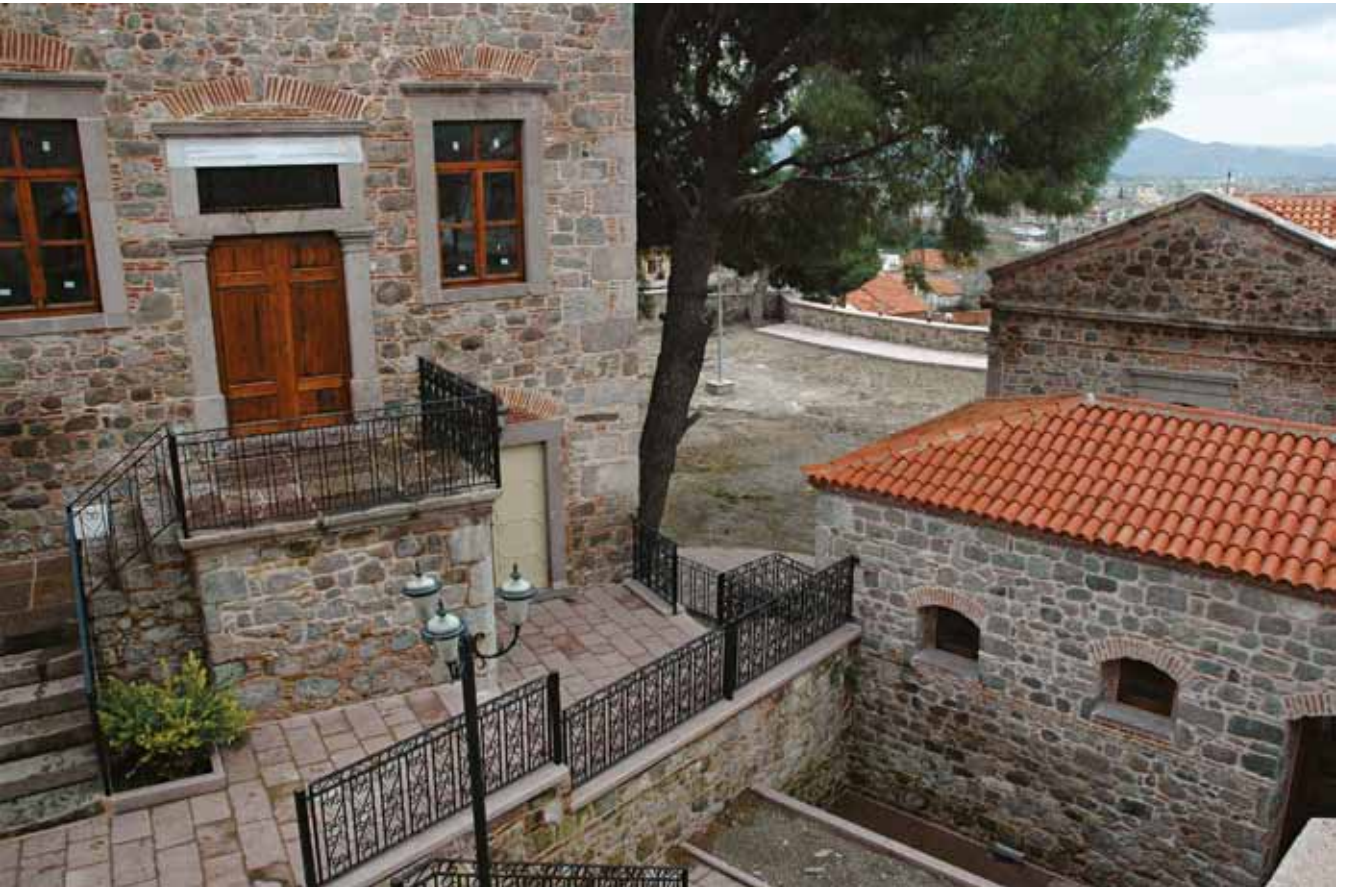
200 Ortak 200 Eser Programı desteğiyle projelendirilen Bergama Gazipaşa İlkokulu Restorasyonu ve Butik Otel
