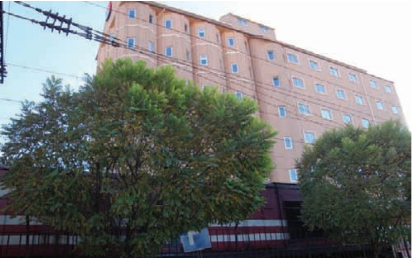
Eskişehir TMO silosunun yeni hali
