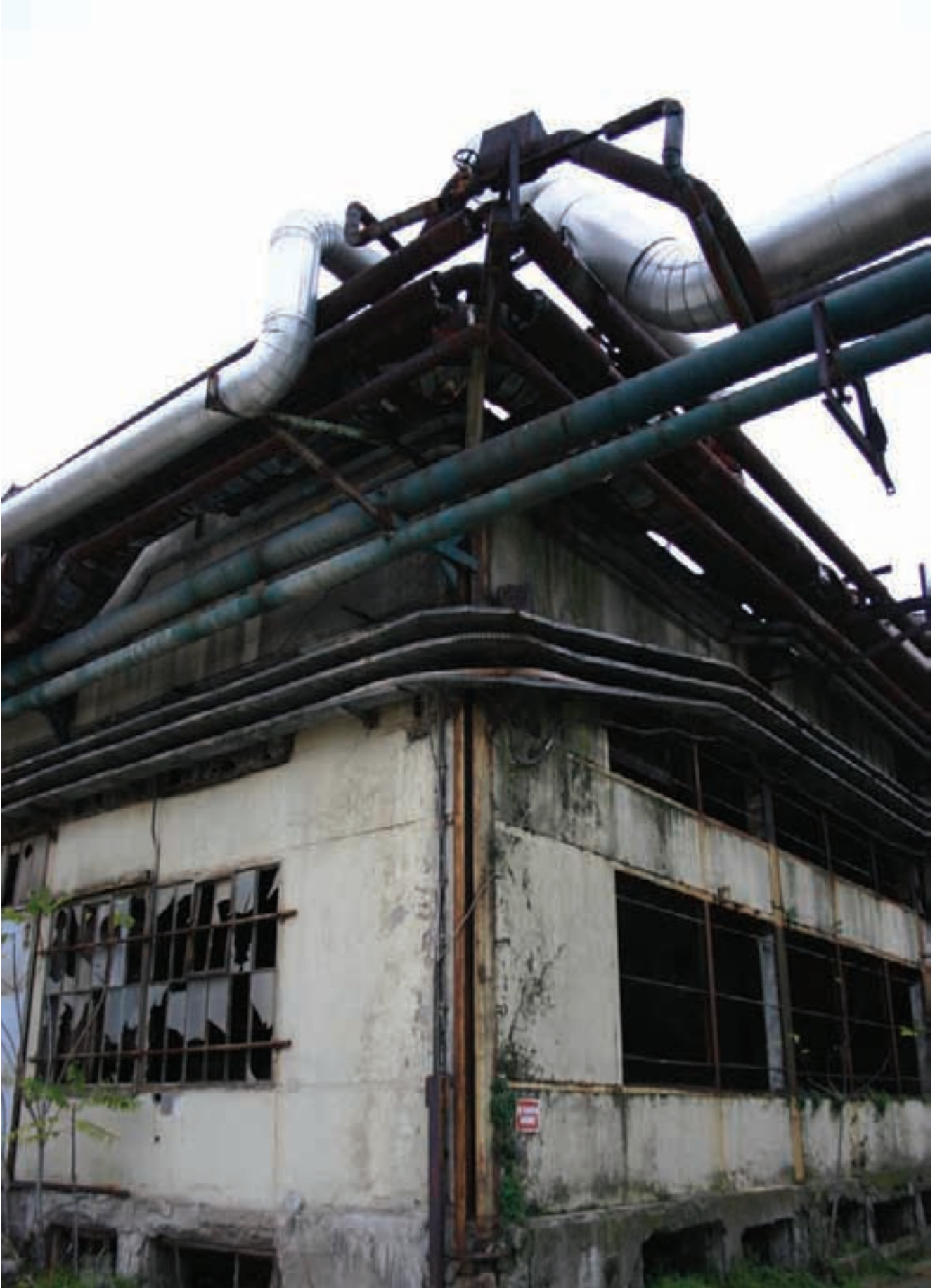
Kocaeli SEKA Fabrikası
