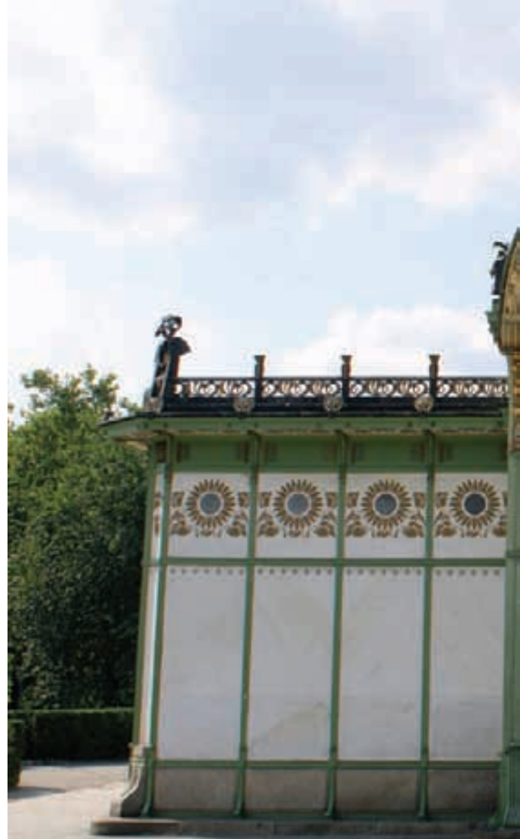
Stadtbahnstation Karlsplatz (Karlsplatz istasyonu), Otto Wagner 1896
