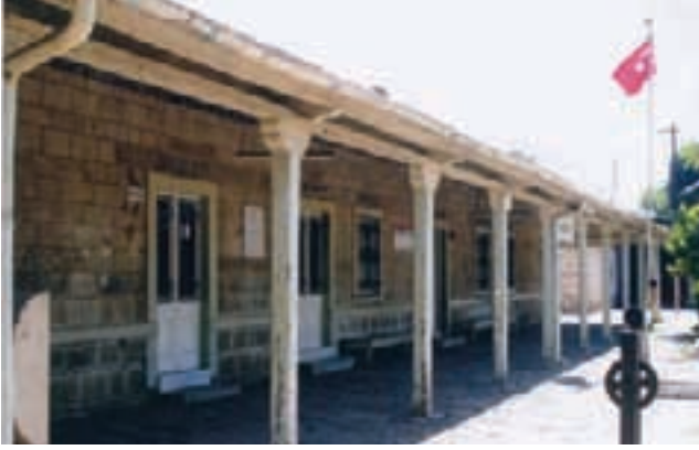
Ödemiş İstasyon Binası
