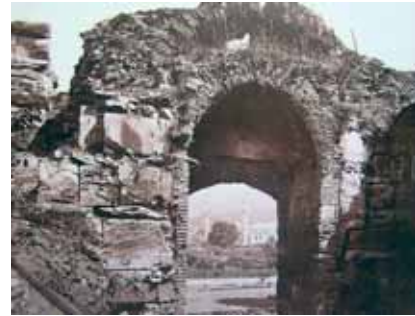
Saltanat kapısı onarılmadan önceki hali
