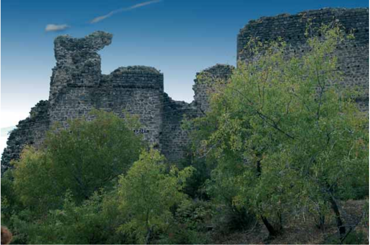
Kale duvarlarının bugünkü durumu
