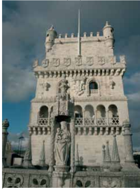
Belem Kulesi, Lizbon - Cephe detayı
